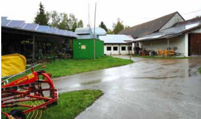
ТЕРРИТОРИЯ ФЕРМЫ, НА КОТОРОЙ УСТАНОВЛЕНА БИОГАЗОВАЯ УСТАНОВКА
